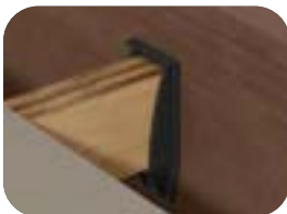
Dispositivo antirruído nos travessões
