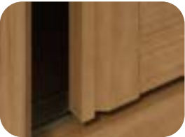
Encabeçamento das portas em MDF de 25mm
